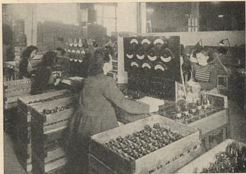
Rampes de traitement des tubes. Les cathodes ne donnent leur maximum d'émission d'électrons que si elles ont subi une « formation ». On voit les batteries de lampes utilisées comme résistances et la surveillance de la formation à l'aide des instruments de mesure.
