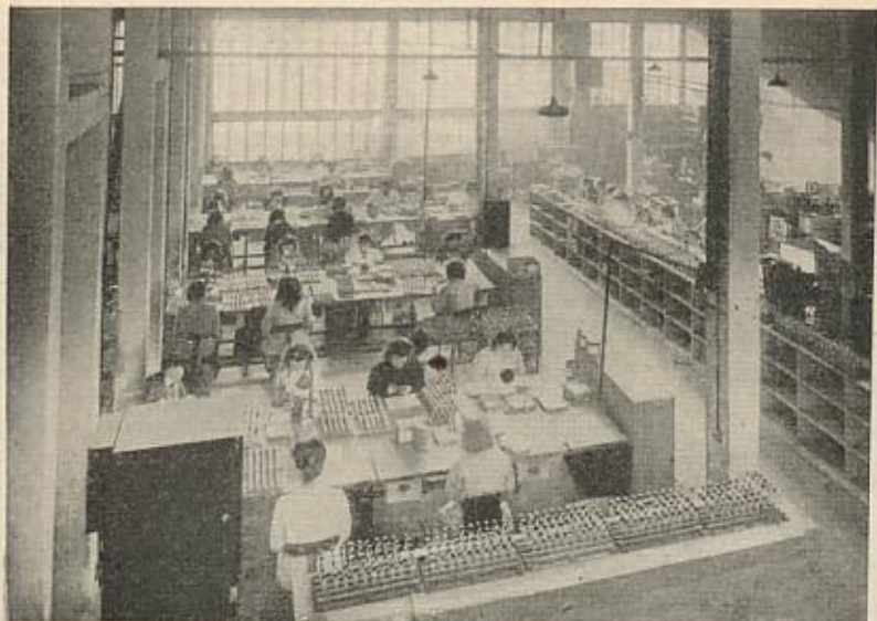
Vue partielle d'un hall de montage à la chaîne. On distingue nettement au deuxième rang, de droite à gauche, l'ordre des opérations : une monteuse, une contrôlease, et ainsi de suite. Les tubes TUNGSRAM sont contrôlés à chaque étape de la fabrication.
